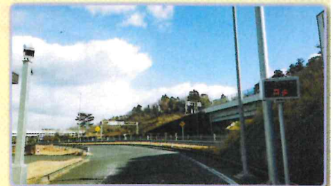
4 ゲートが開いたら、直進して新空港自動車道に合流
